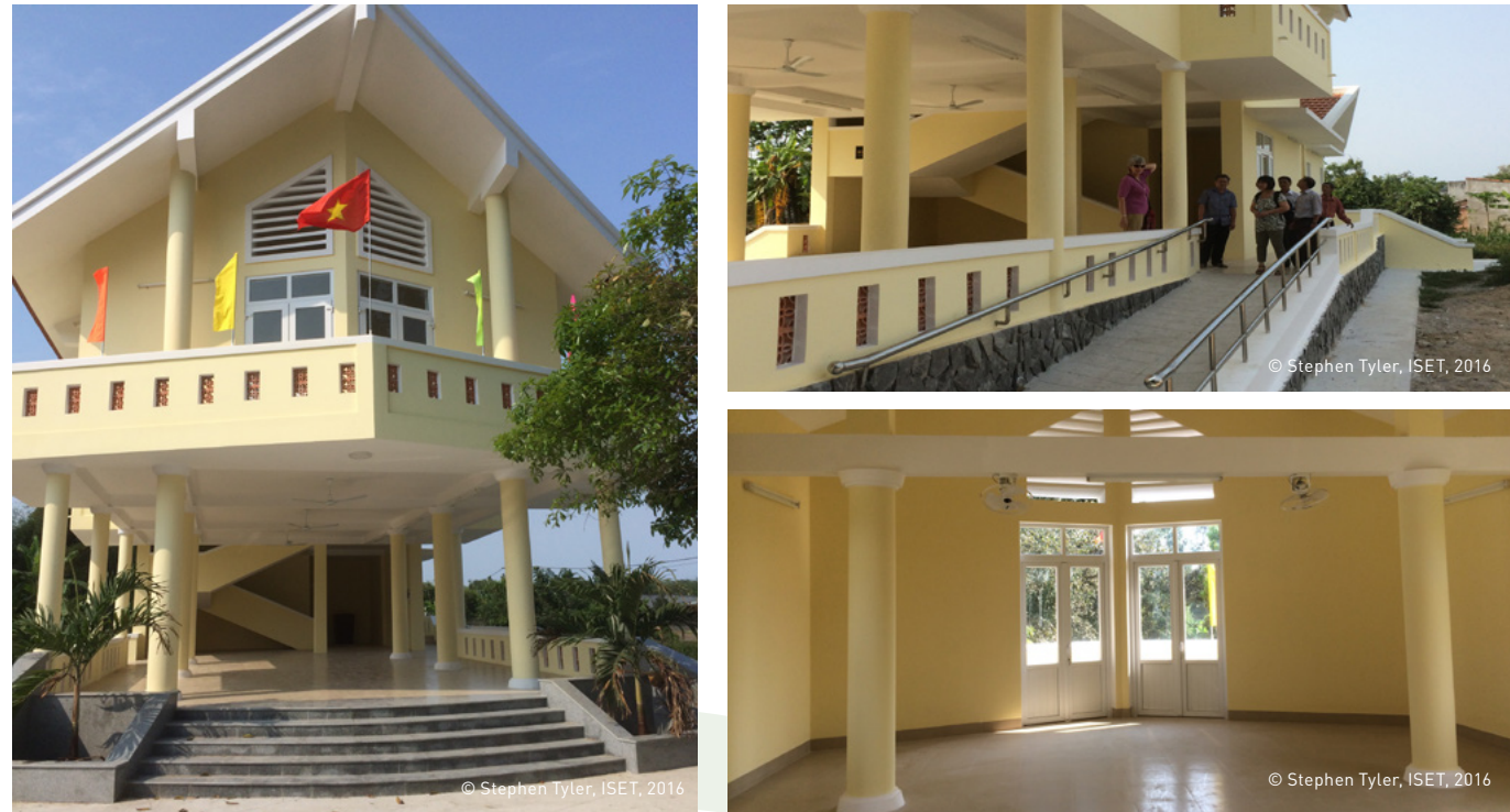
HÌNH 1 NHÀ TRÁNH LŨ AN TOÀN
