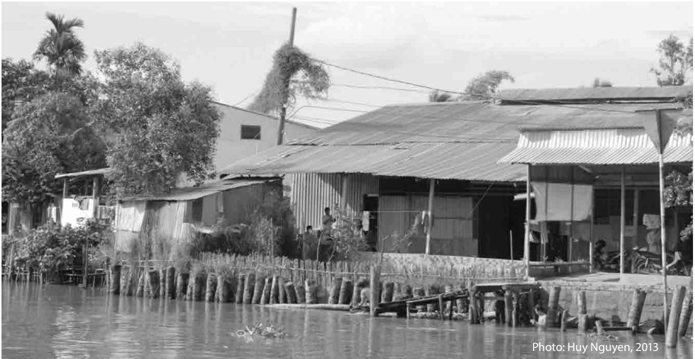
HÌNH 1. BỜ KÈ BẰNG THÂN DỪA VÀ TRE DO NGƯỜI DÂN ĐỊA PHƯƠNG XÂY DỰNG
